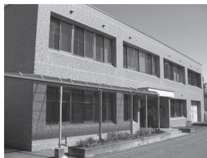
センター建物外観
